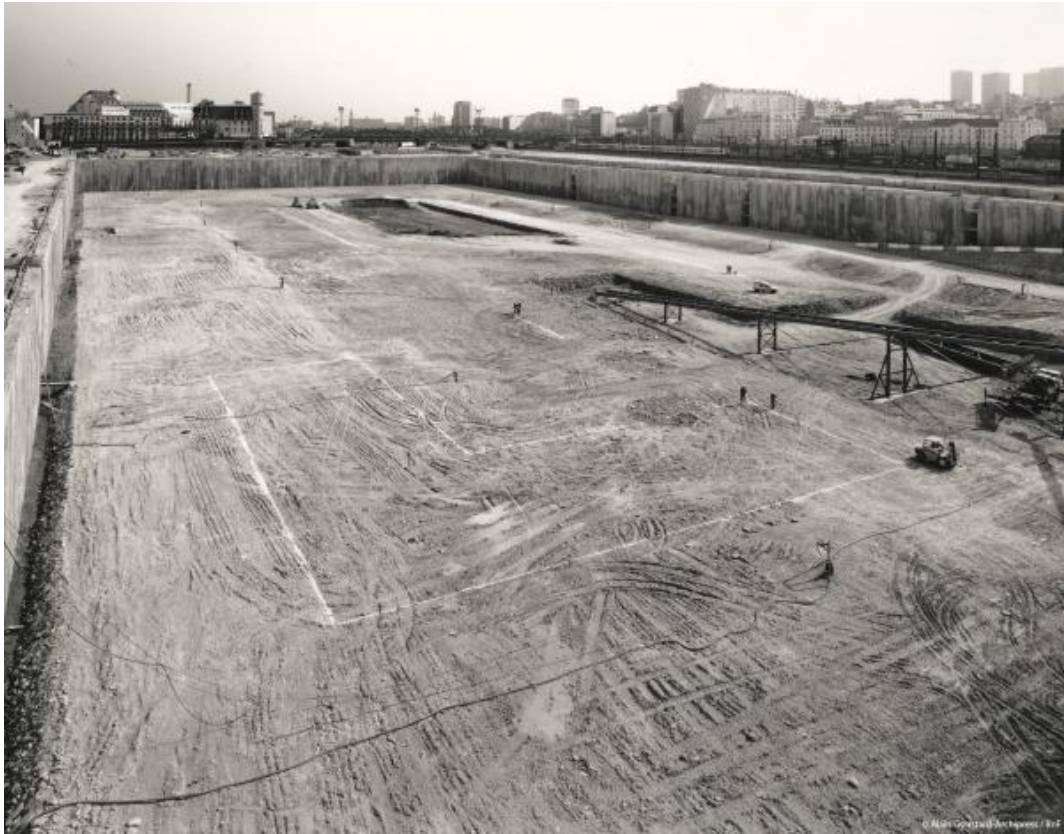
1 Paroi de béton sur le périmètre du site
