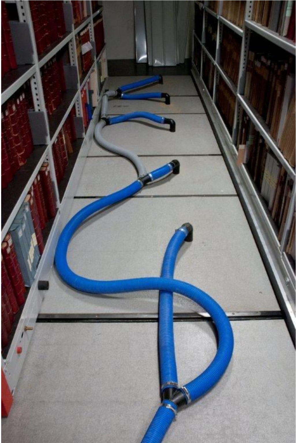
Extraction de l'humidité dans les planchers des compactus
