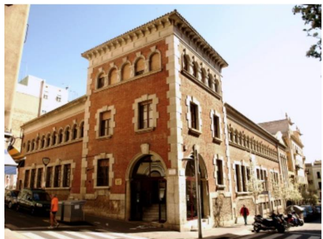
Figura 2. Biblioteca pública de tarragona
